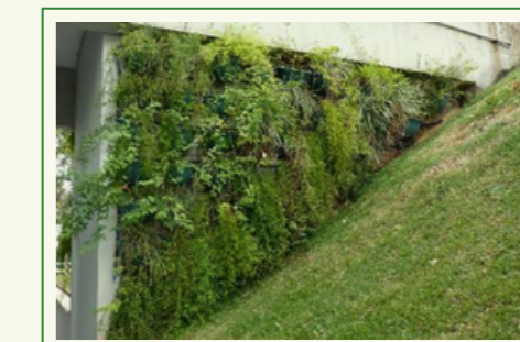
Rampa do prédio A: jardim vertical com irrigação automática.
